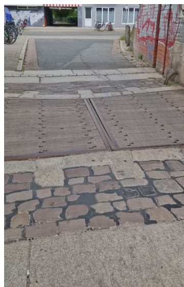
Bild A Unterführung Boden (Auf dem Rückweg)
