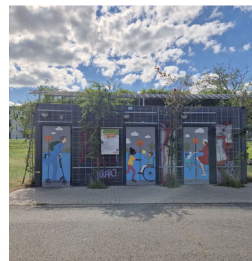
Bild E Toiletten
